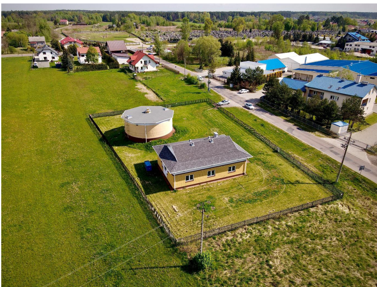
Zdjęcie nr 1: Stacja Uzdatniania wody w Klembowie. Opracowanie własne.
