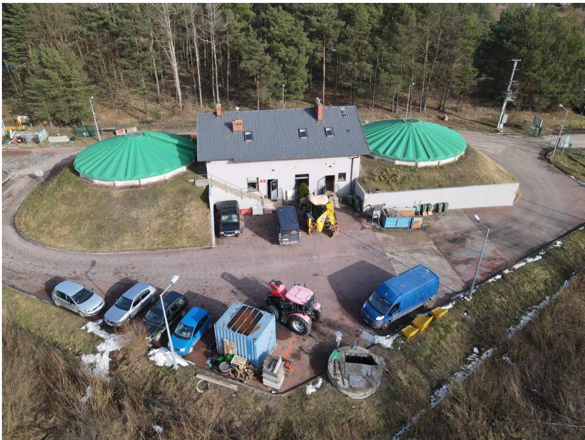
Zdjęcie 1: Oczyszczalnia ścieków przy w Klembowie przy ulicy Miłej 15. Opracowanie własne.
