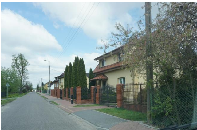
Roślinność ozdobna przy zabudowie mieszkalnej zagrodowej
