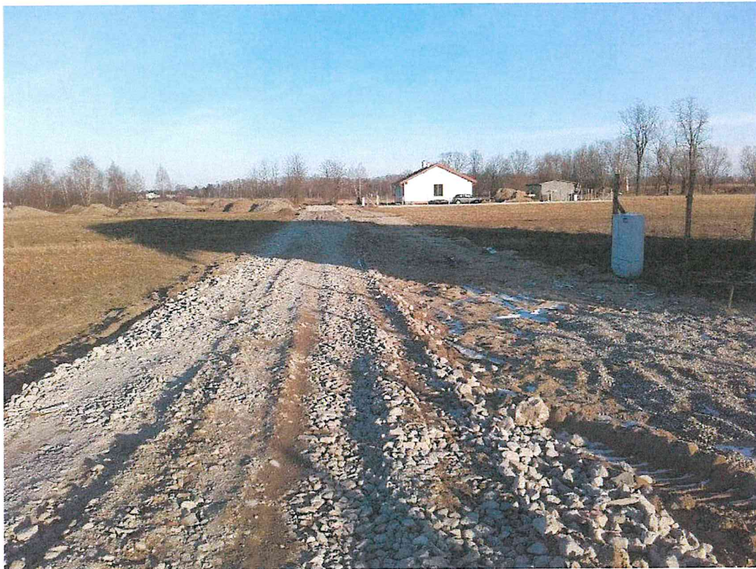
Foto nr2. Ulica Kresowa cd . Tworzą się koleiny. Gruz zmieszany z gruntem.
