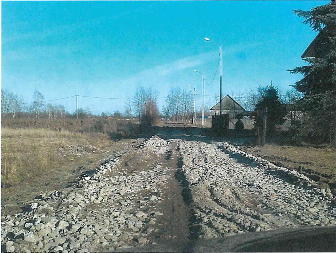
Foto nr 11. Ulica Brzozowa cd. Stan po naprawie . Widoczne koleiny –ryzyko zaczepienia podwoziem samochodu osobowego.
