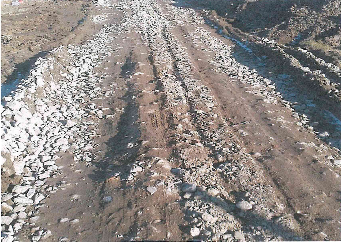
Foto nr 7. Ulica Brzozowa cd. Widoczne koleiny –ryzyko zaczepienia podwoziem samochodu osobowego.
