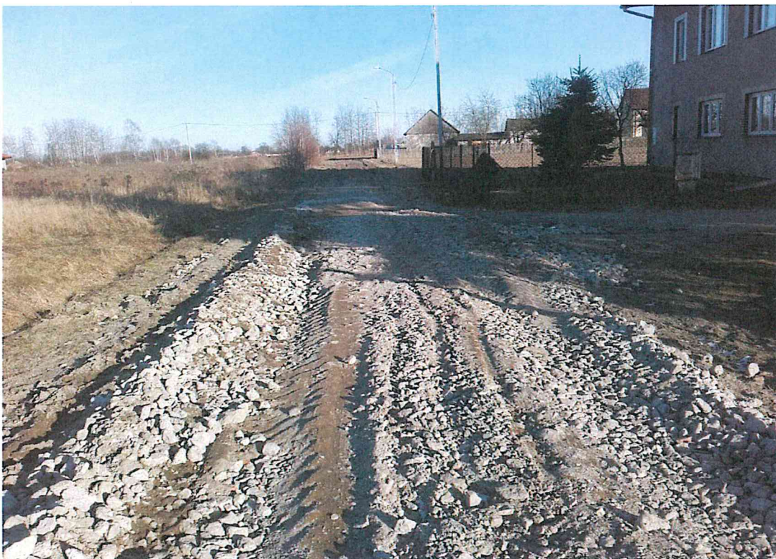
Foto nr 11. Ulica Brzozowa cd. Stan po naprawie . Widoczne koleiny –ryzyko zaczepienia podwoziem samochodu osobowego.
